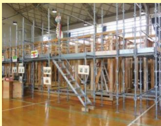
▲木造住宅の新築工事
