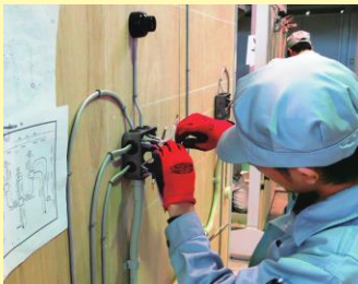
▲配管・配線工事
