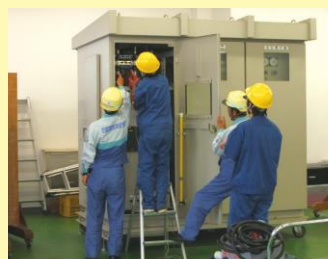
▲受変電設備点検
