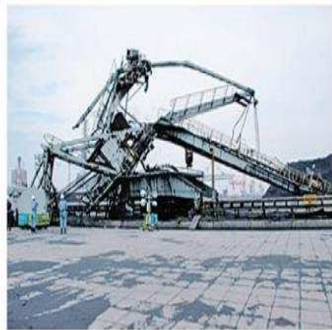
クレーンの崩落災害
