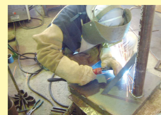
▲作業台の製作
