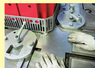
▲機械による切断
