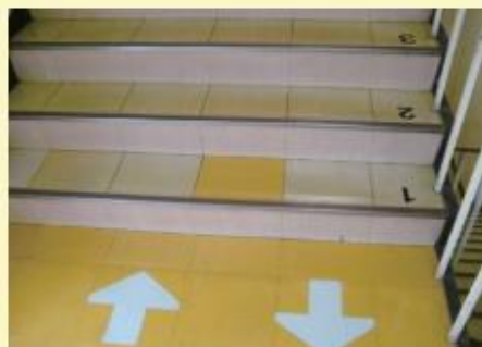
階段に通行区分を明示するとともに、事故が起こりやすい最後の3段にカウントダウンの表示をして、注意喚起を行っている。
