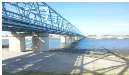
工事完成写真
