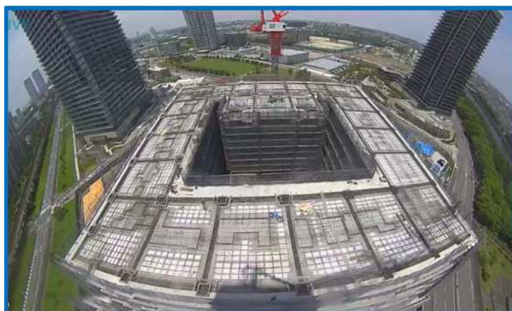
タワークレーン搭載のカメラから撮影
