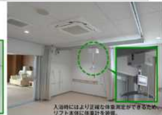
入浴時にはより正確な体重測定ができるため、リフト本体に体重計を装備。
