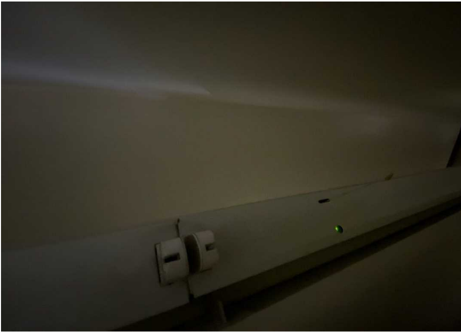
千葉公共職業安定所 利用者用階段踊り場 鉄パネル裏照明器具
