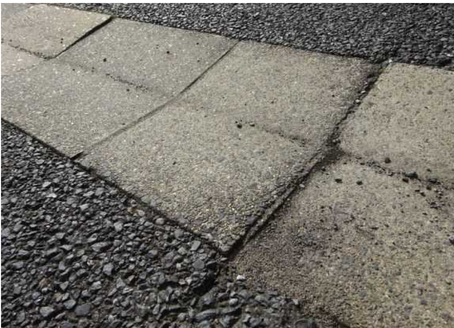
千葉公共職業安定所 駐車場 側溝
