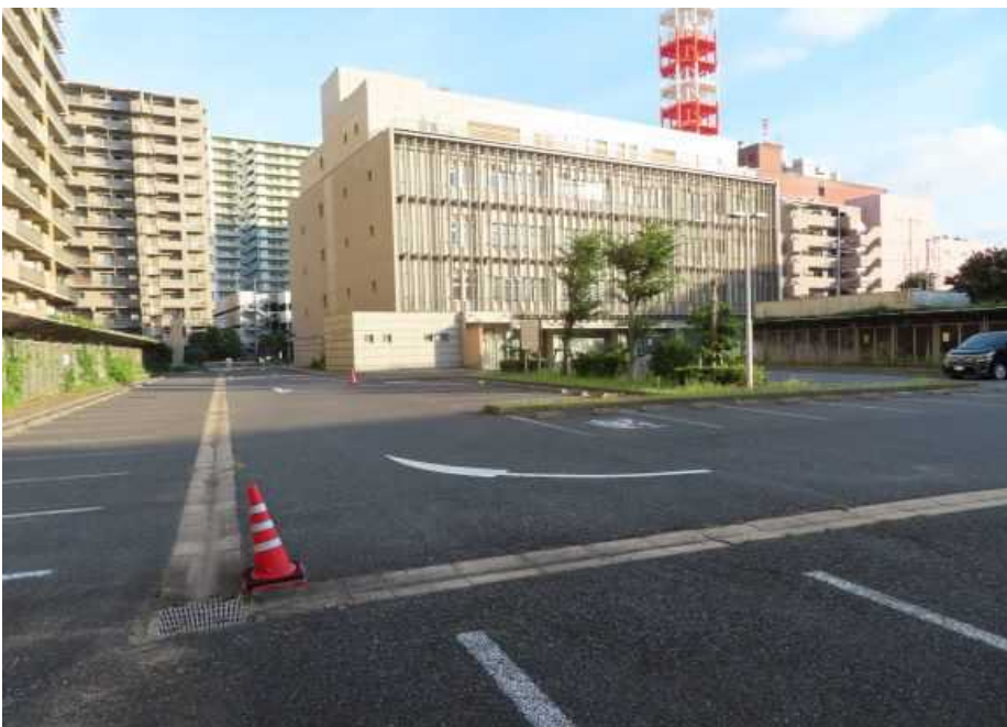
千葉公共職業安定所 駐車場 側溝
