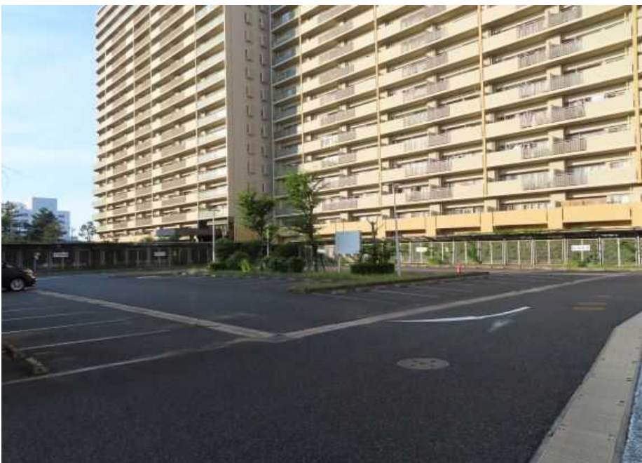
千葉公共職業安定所 駐車場 側溝
