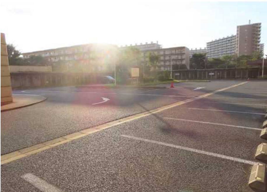
千葉公共職業安定所 駐車場 側溝
