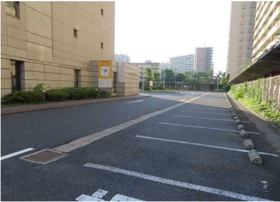
千葉公共職業安定所 駐車場 側溝
