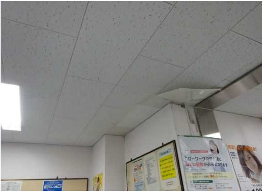
成田公共職業安定所 からべ庁舎 1階事務室内 状態
