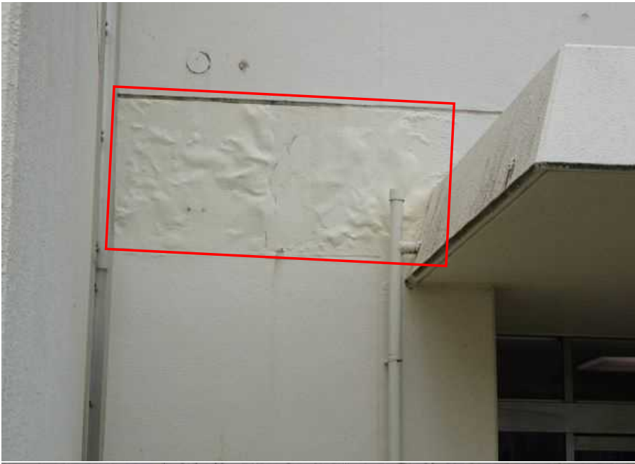
成田公共職業安定所 からべ庁舎 外壁南側
