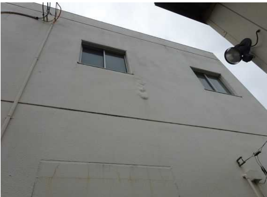
成田公共職業安定所 からべ庁舎 外壁東側 状態
