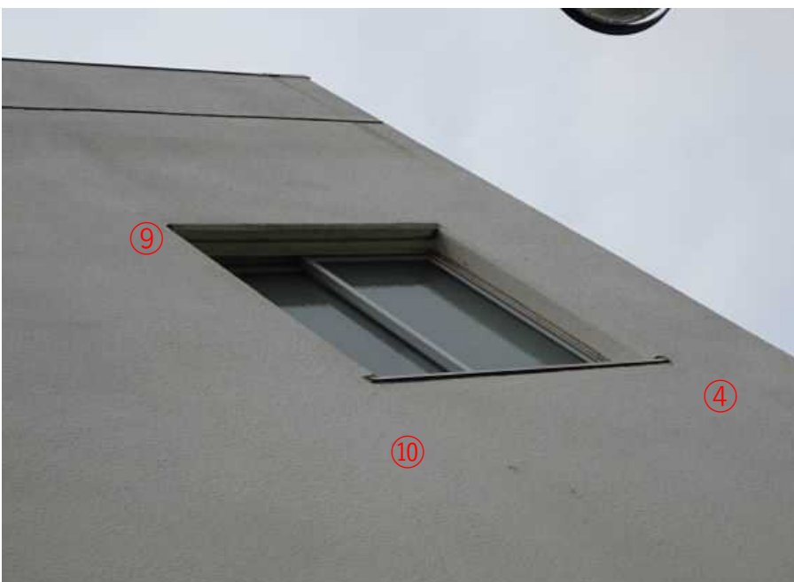
成田公共職業安定所 からべ庁舎 外壁東側
