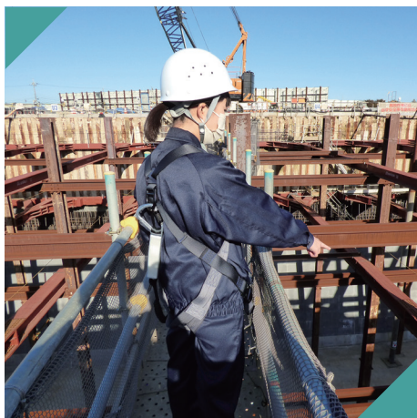
▲ 建設現場での安全確認
