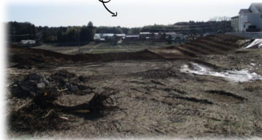
印西市内の造成工事
