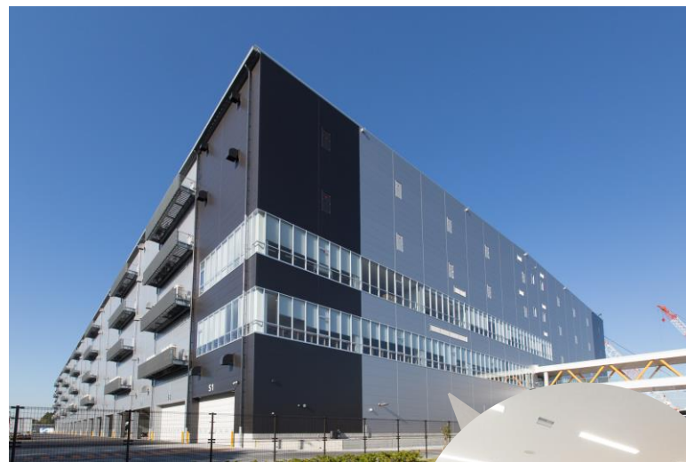
綺麗な食堂がある物流倉庫もあります！ （印西ロジスティクスセンター）
