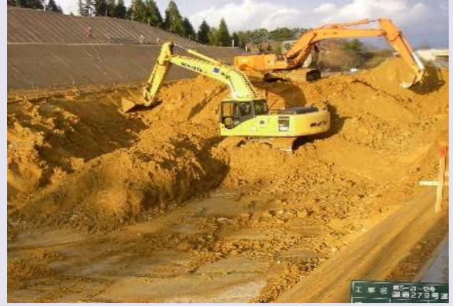
○ バックホウでの掘削作業です
