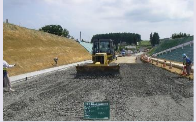
○ ICTが進んでいます、データの入力作業中です ○ ブルでの石均作業です
