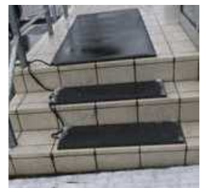
<ヒートマットの設置例>
