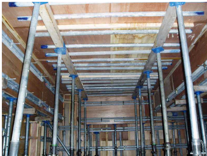
図 5一型 枠支保工
