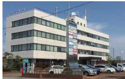
本社(湯沢セントラルビル)
