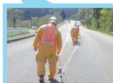
施工風景 ラインを引く前工程
