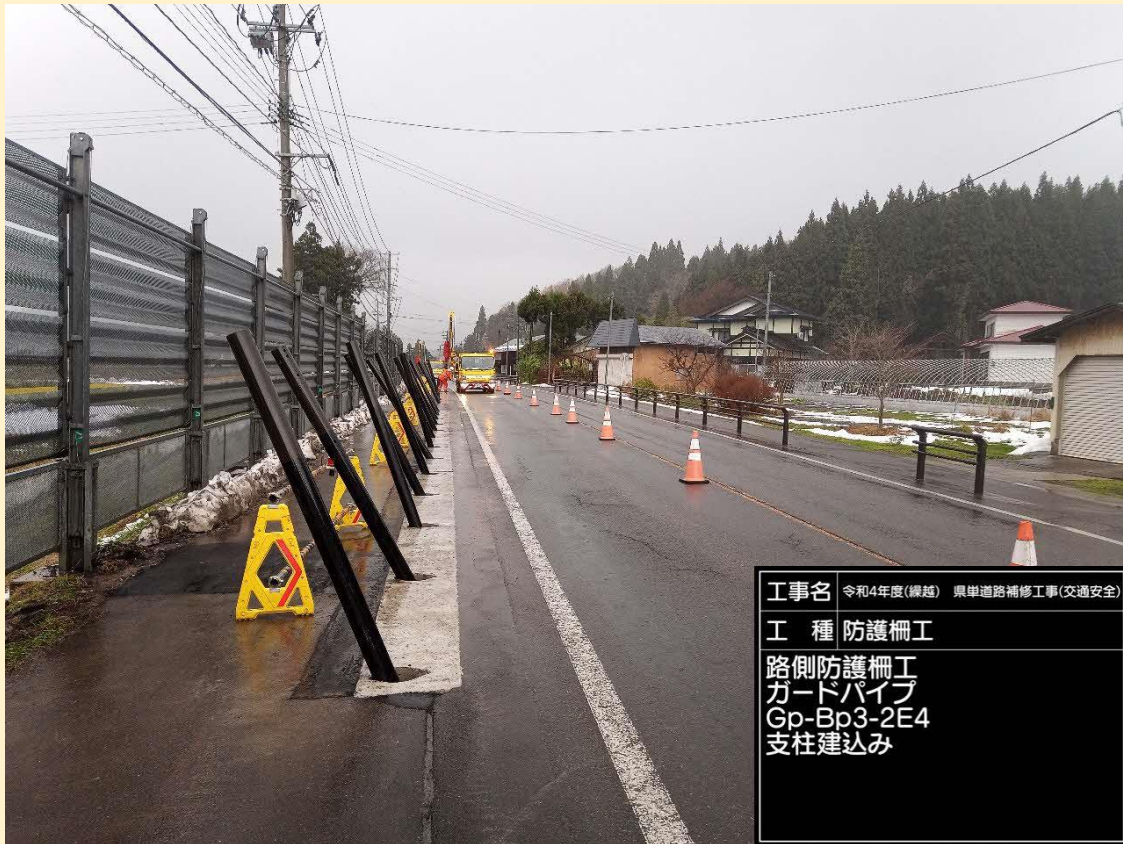
国道 1 0 5 号線 ガードパイプ施工 第 1 7 回秋田県優良工事地域振興局長表彰
