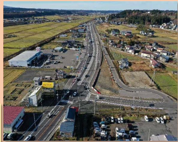
上石川地区道路改良舗装工事 (国道13号線河辺)
