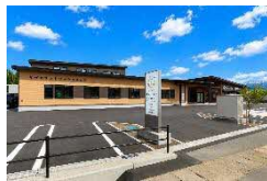
クリニック・薬局新築工事
