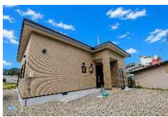
住居新築工事
