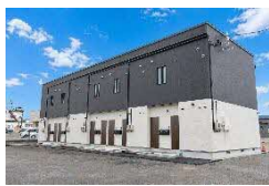
共同住宅新築工事
