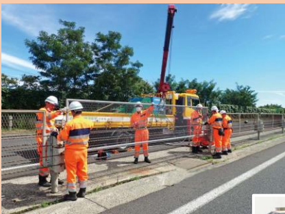
交通事故復旧作業
