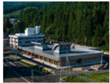
湯沢市皆瀬庁舎建築工事(電気設備)
