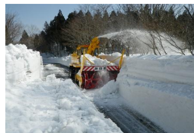
道路除排雪作業業務委託(秋田県)
