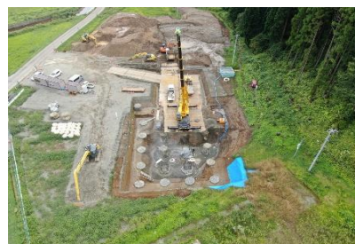
鳥海ダム百宅線4号橋下部工(P3)工事 (鳥海ダム工事事務所)
