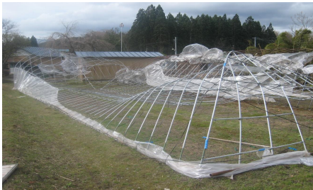
台風によるハウスの被害
