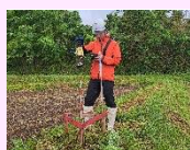
現場へ（測量・丁張り等）
