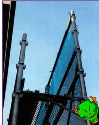
足場の妻側に手すり、中さん、幅木が未設置だった事例 (写真は違反指摘時の状況) 足場の外側と内側の設置方法は適切
