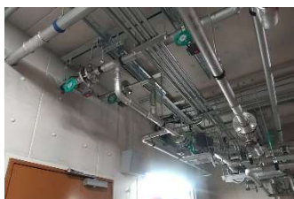
各種配管工事
