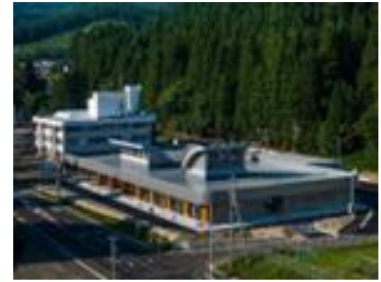
湯沢市皆瀬庁舎建築工事(電気設備)
