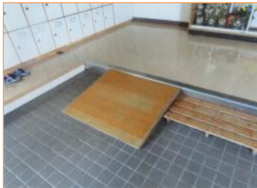
既存の段差にスロープを設置した事例
