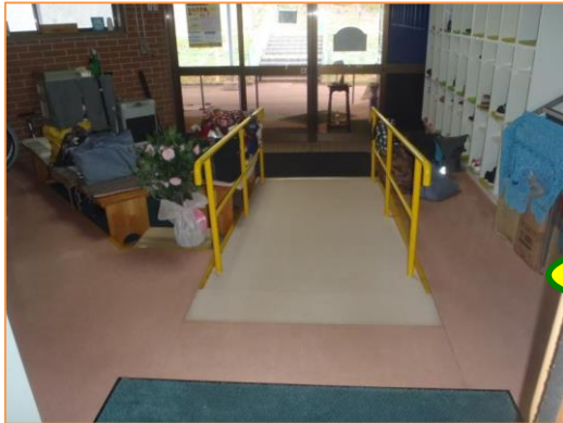
滑りにくい床と、スロープ及び手すりを設置した事例
