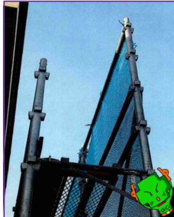
足場の妻側に手すり、中さん、幅木が未設置だった事例 (写真は違反指摘時の状況) 足場の外側と内側の設置方法は適切
