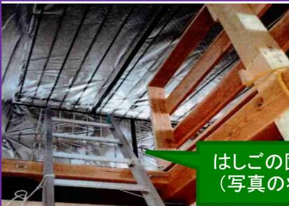
常設階段を設置する前の開口部に手すり等が未設置だった事例 (写真は改善後の状況)
