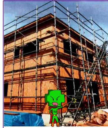
昇降設備に手すりの中さんが未設置だった事例 (写真は違反指摘時の状況)
