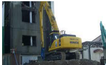
建造物解体工事
