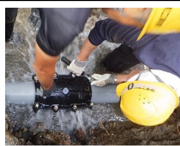
水道管漏水修理
