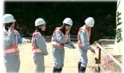
女性職員による現場パトロール
