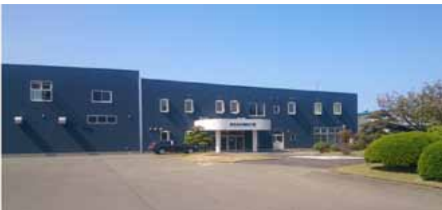
2019年1月完成の新社屋
