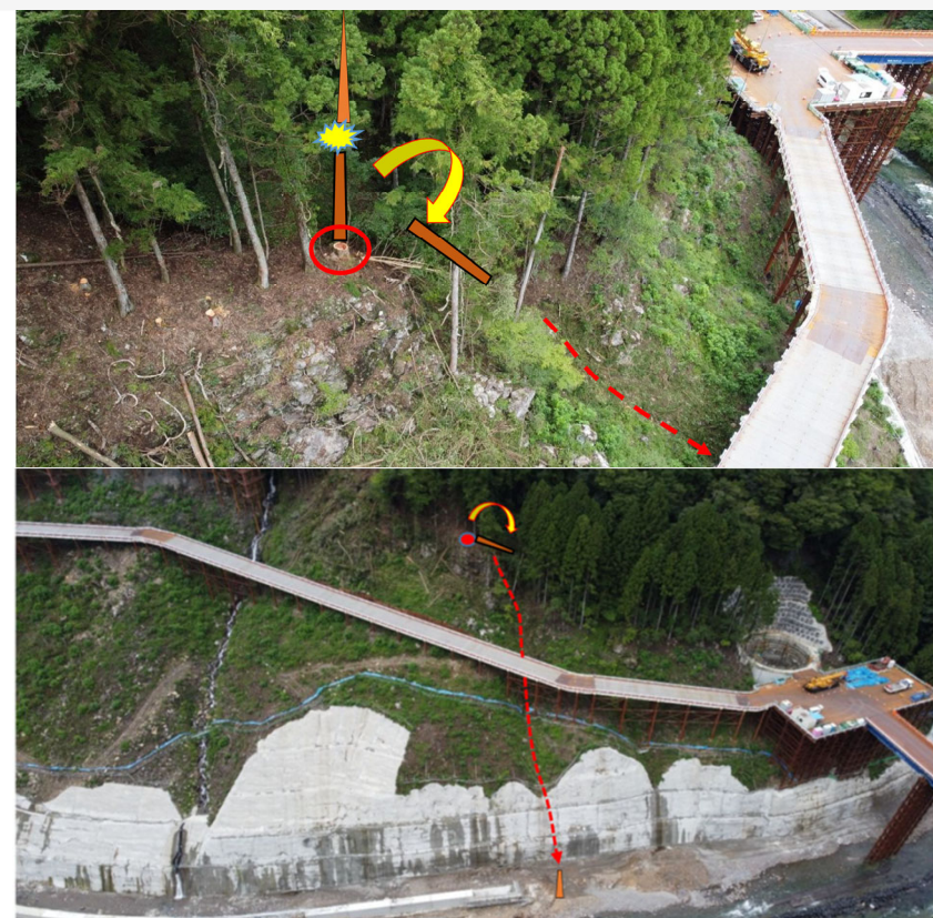
施工狀況写真
