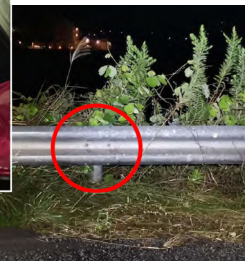
ガードレール損傷部
