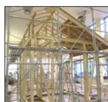
④木造住宅の施工法を理解する
