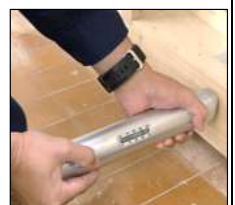
⑥建築物の劣化診断
