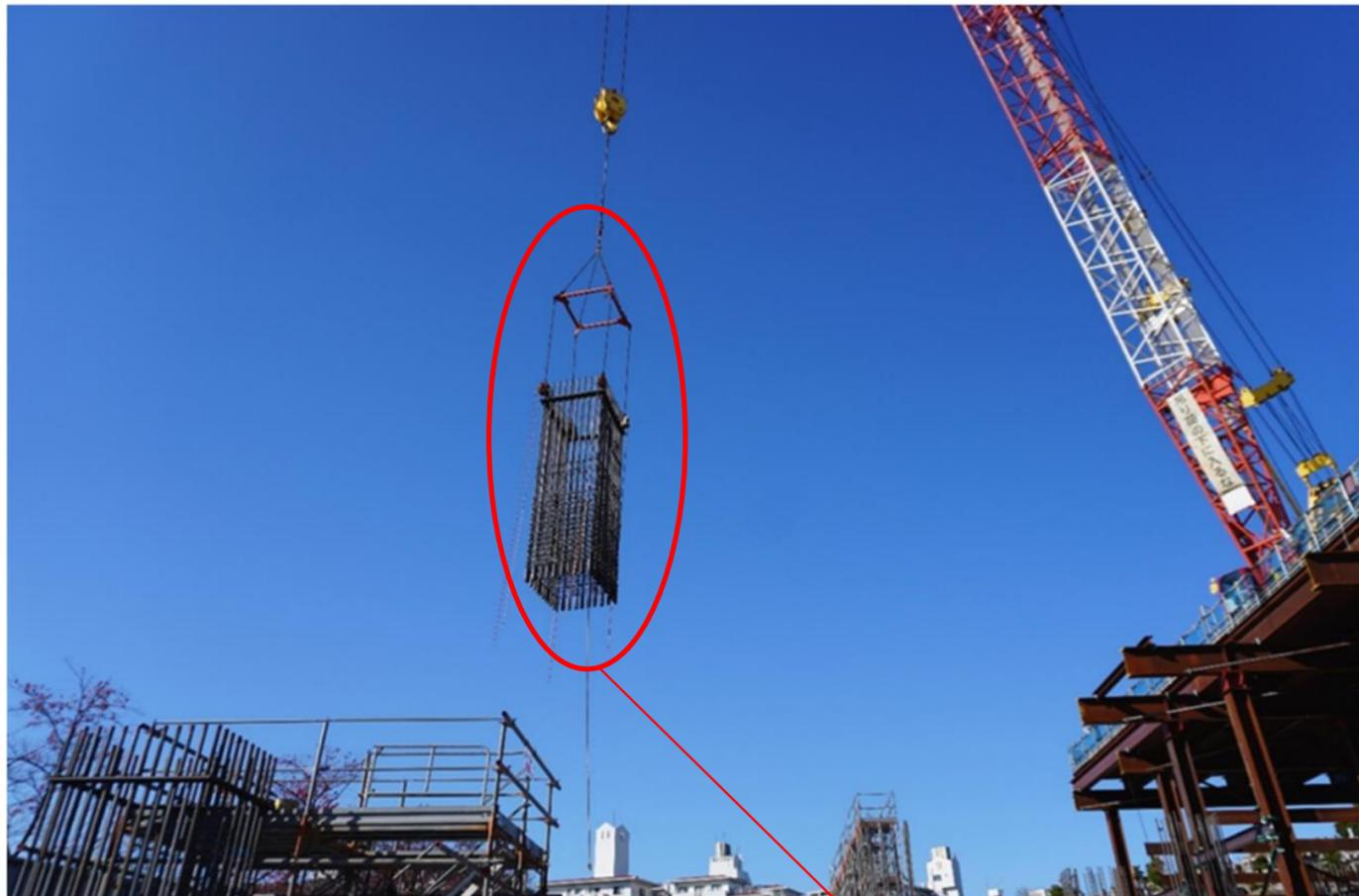
鉄筋をクレーンで吊り上げ、所定の位置まで移動させる様子
