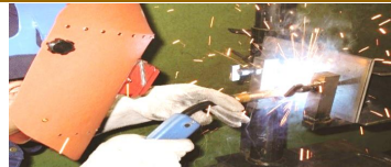
炭酸ガスアーク溶接(ワイヤが自動送給されてくる半自動溶接です。鉄鋼材料の)
