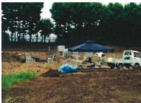
写真 7 : 現場に設置したテント
