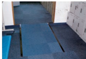
スロープの設置
