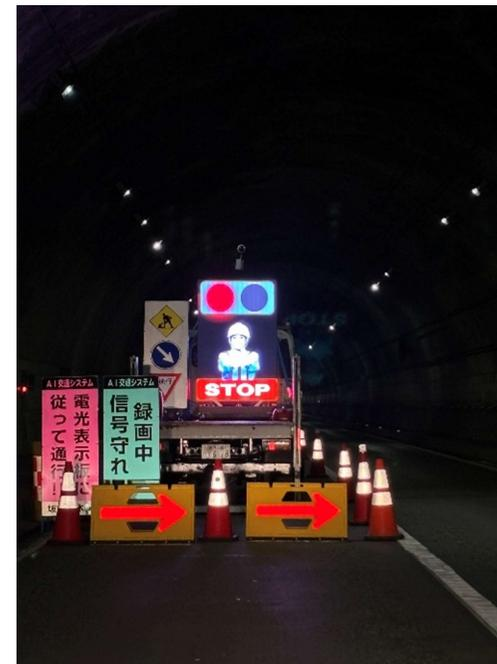
ディスプレイの上のカメラで得た映像をAIが解析して最適な時間で交通制御をします。この写真には警備員が一人も映っていません。少し離れた場所でコントローラーを身に着けています。
