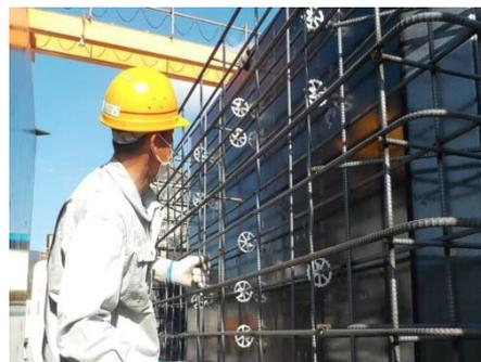
▲鉄筋コンクリートを作るためにクレーンで鉄筋カゴを型枠に入れる様子
