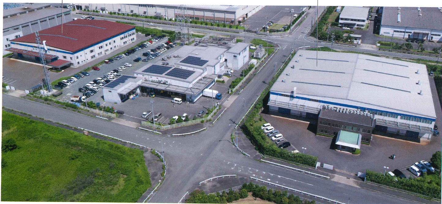
本社・第一工場 ●
