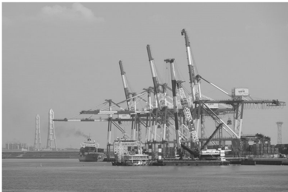
鍋田埠頭のガントリークレーン
