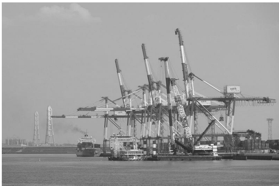
鍋田埠頭のガントリークレーン
