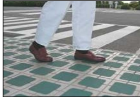
屋外通路の滑り止めシール
