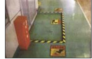
内扉の段差に注意喚起
