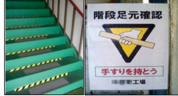
階段の滑り止めシールと注意喚起
