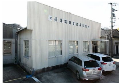
(旧本社) 現在本社屋立替工事中です。
