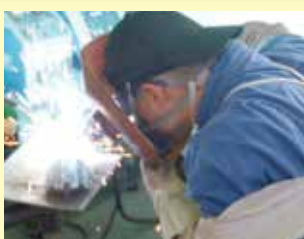
半自動アーク 溶接作業
