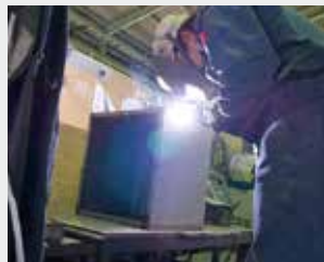
配電ボックスの溶接作業
