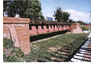
プレートガードー橋
